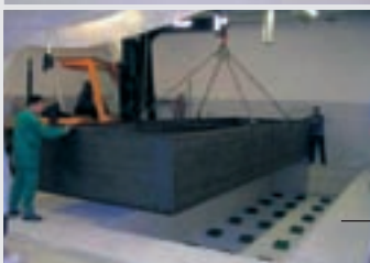
Vorgefertigte Schalung, Filigranplatten oder Stahlform
