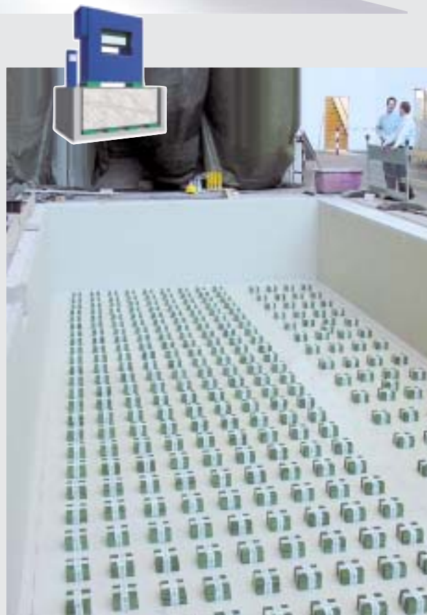
Exemple d'application Société Miele phase 1: mise en place des kits de plaques BILZ
