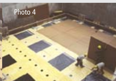
Exemple d'application Société Miele phase 1: mise en place des kits de plaques BILZ
